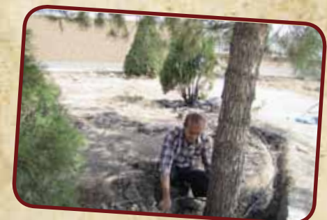
❖ اجرای سیستم آبیاری قطره ای فضای سبز خانه بهداشت ازیران به همت جمعی از خیرین محترم
