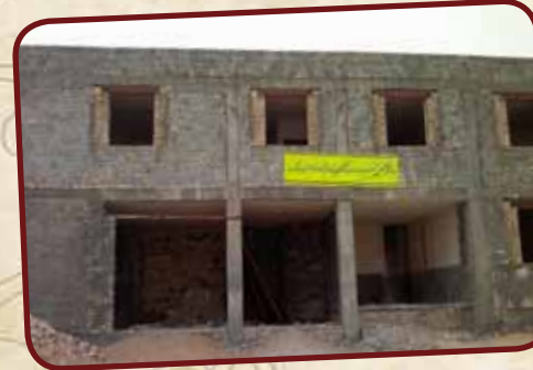
❖ ساختمان در دست احداث خیریه امام رضا (ع)
