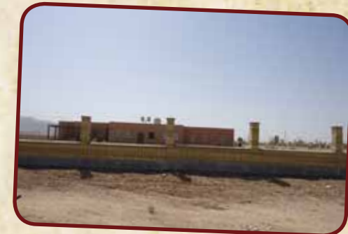
❖ بهسازی، بتون ریزی و محوطه سازی مرکز بهداشتی درمانی جندق به همت خیرین محترم
