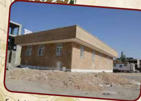
اتمام نازک کاری ساختمان اورژانس ۱۱۵ شهرک سیمرغ خورزوق به همت شهرداری خورزوق
